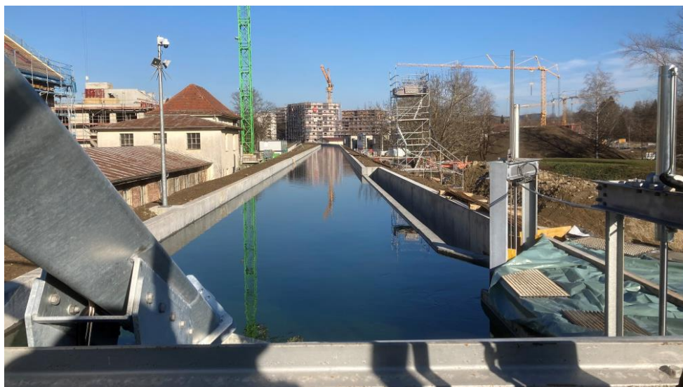
Abbildung 2: Einlaufbereich am Krafthaus, Blick stromaufwärts
