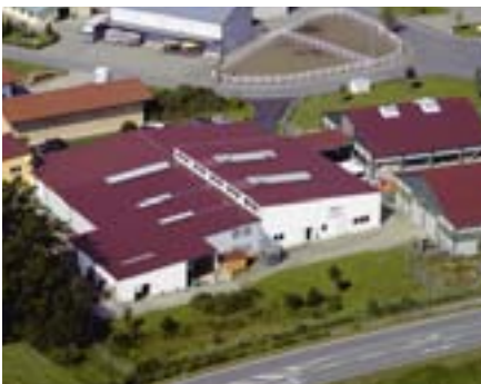
Firmengebäude für Fertigung und Lagerhaltung
