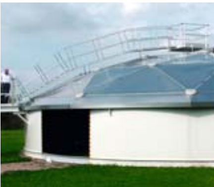
Laufsteg auf Dome-Dach • Access stairs & decks on silo tops
