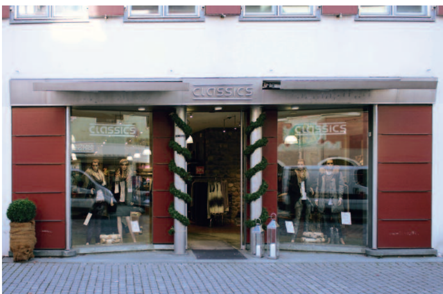
Schaufenster, die sich in die Fassade eingliedern
