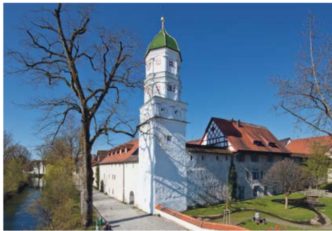
Pulverturm mit Argenufer und Argen
